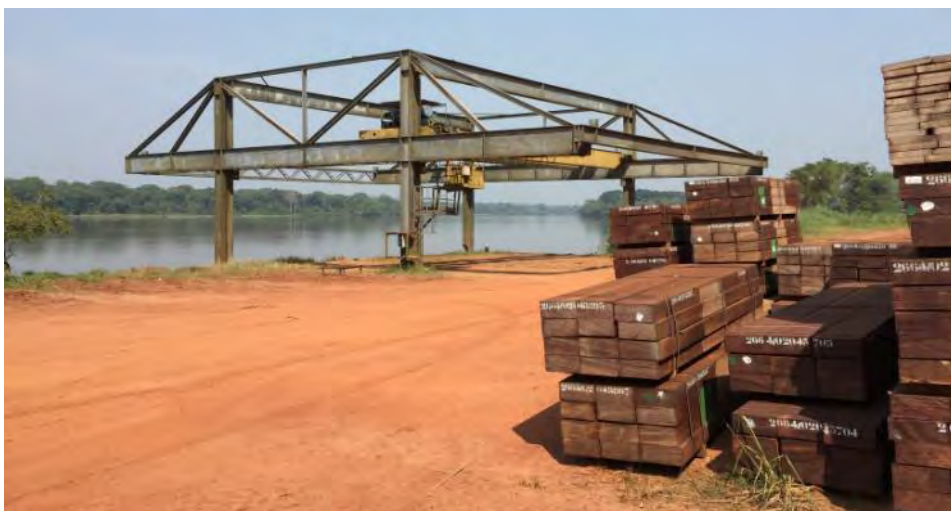
Figure 36 : Quai de chargement de barges de la société IFO sur la Sangha
