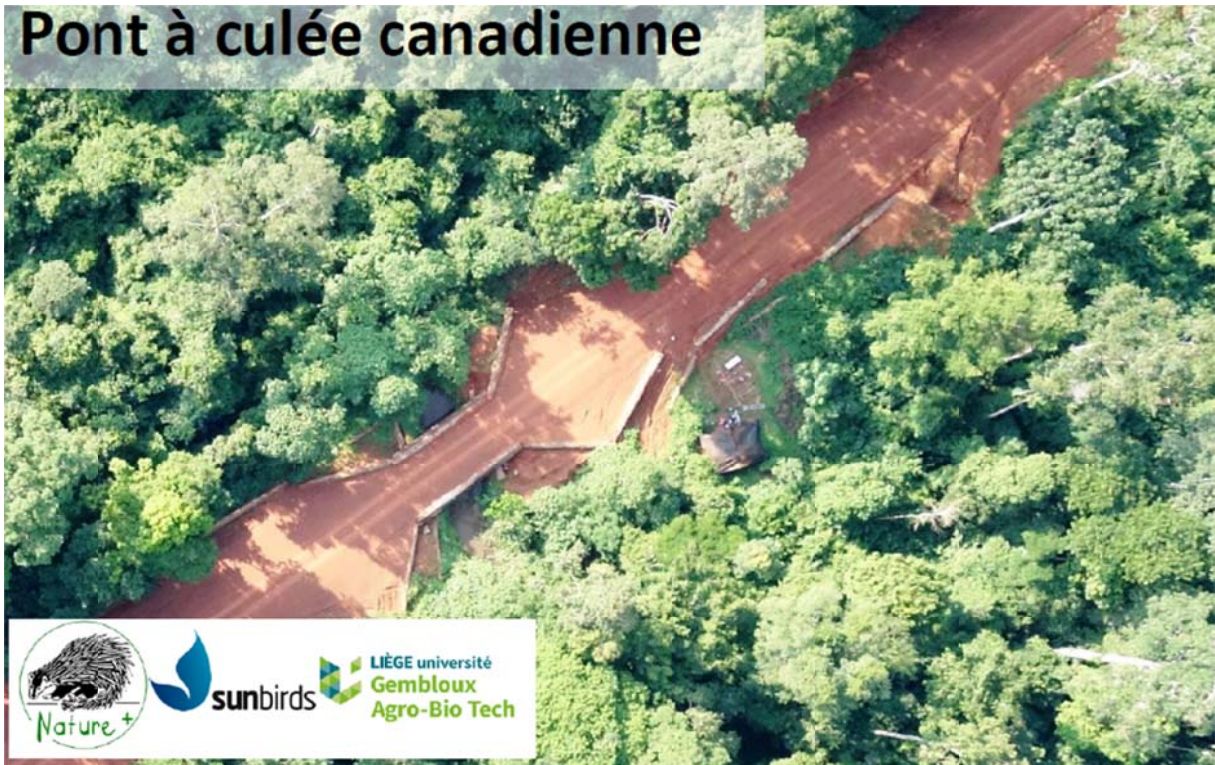
Figure 32 : Photos géolocalisées des ponts à culée canadienne
