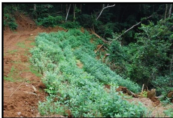
En remblai, des branches rejetables d'une longueur de 2 à 4 m sont posées sur une surface légèrement inclinée vers l'arrière en laissant dépasser les branches d'environ 10–20 cm. Ensuite, on poursuit le remblayage et le compactage jusqu'à la prochaine rangée. L'intervalle entre les rangs est déterminé selon le matériel de remblayage, la pente, la stabilité et la hauteur du remblai, jamais inférieure à 150 cm.
