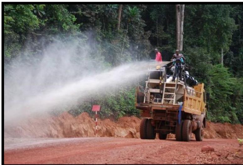
L'ensemencement hydraulique est une technique notamment très adaptée lorsque de grandes / nombreuses surfaces sont à revégétaliser. Cette technique permet de travailler rapidement sur toutes sortes de terrain et elle garantit généralement un résultat optimal en un seul passage.
