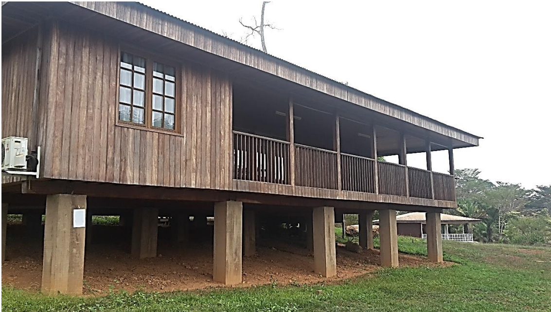
Photo 10 - Construction réalisée par Pallisco-CIFM réalisée à partir de déchets d'exploitation
