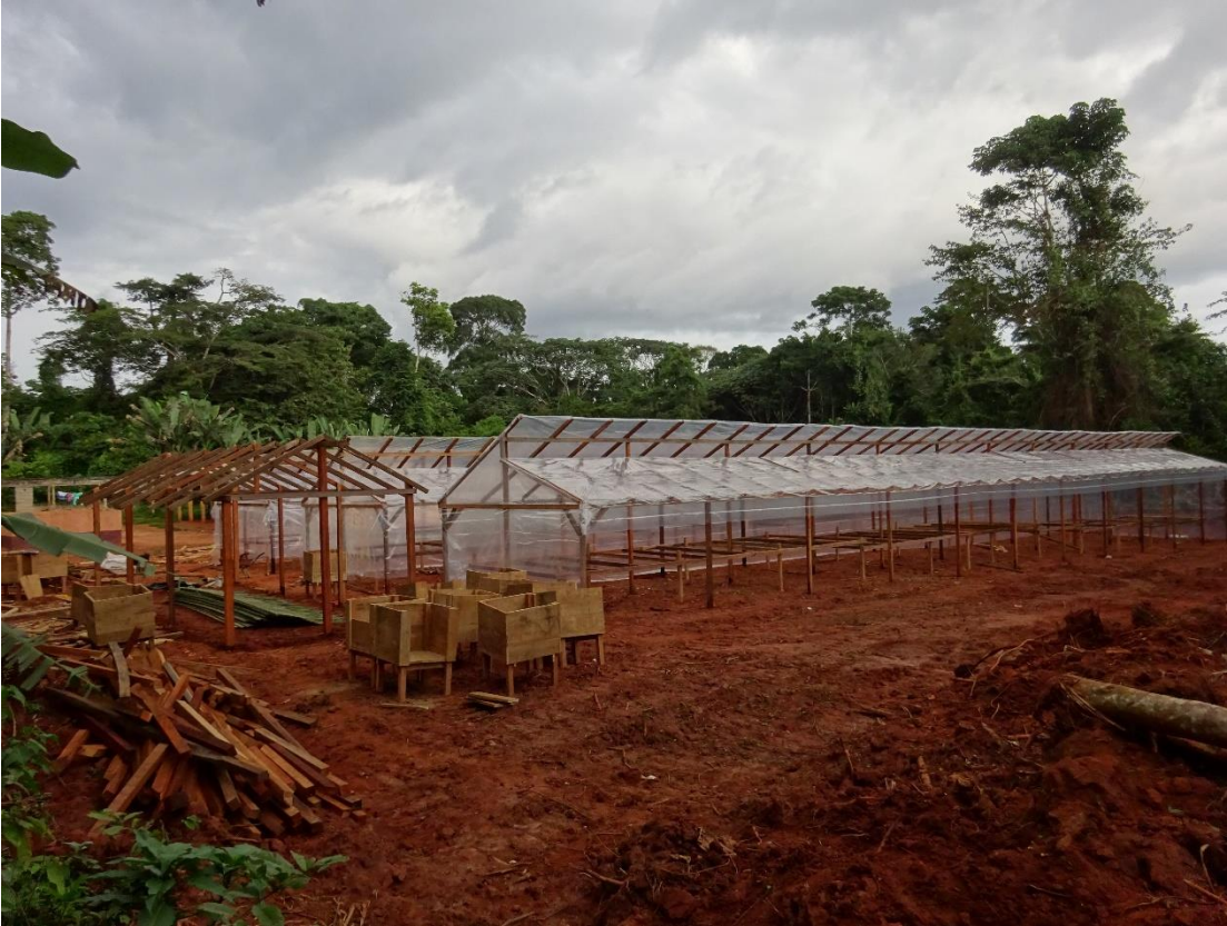
Centre de fermentation en cours de construction ©RH
