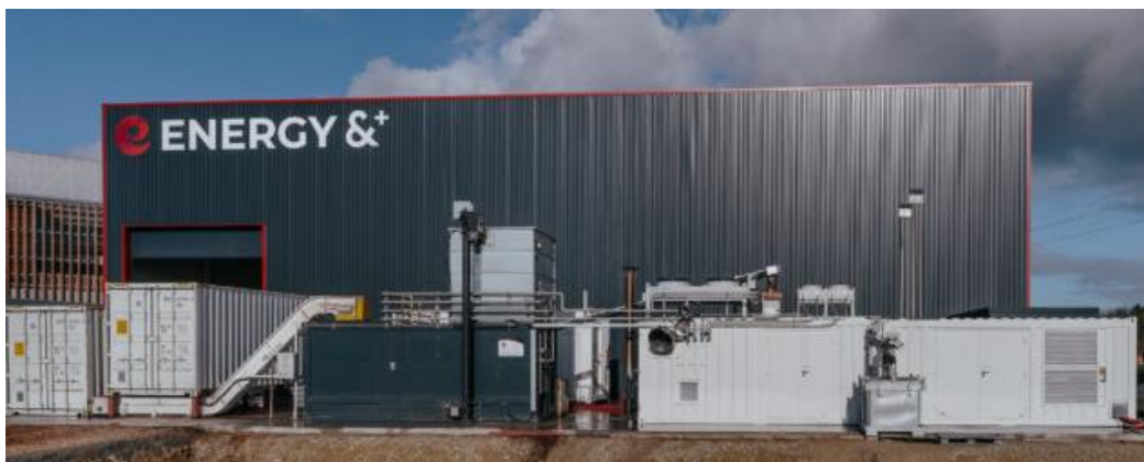
Figure 41 – Photographie des modules de pyrogazéification installés à Yangambi (crédit image : Energy&+)
