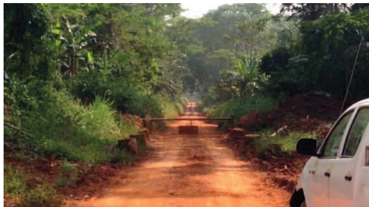
Figure 6, Voie d'entrée/sortie de l'UFA 10054
