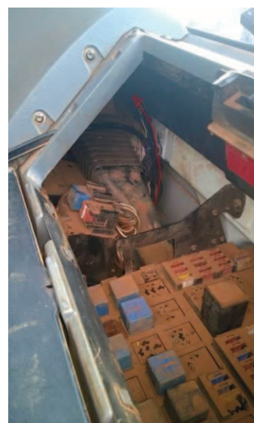
Figure 17, Installation du kit sous le tableau de bord. La flèche rouge indique l'endroit où le boîtier est fixé
