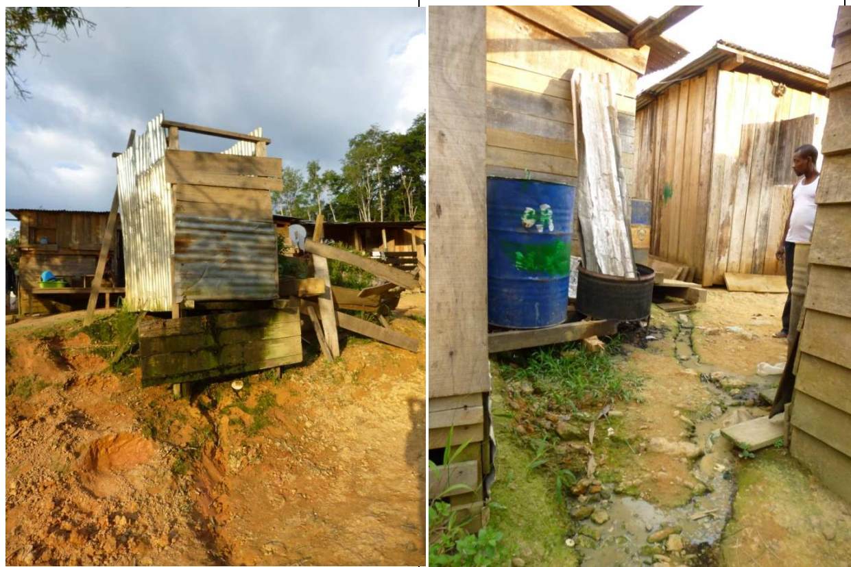
Figure 3 : Latrine perché suite au phénomène d'érosion et écoulement des eaux usées dans camp Bangos
