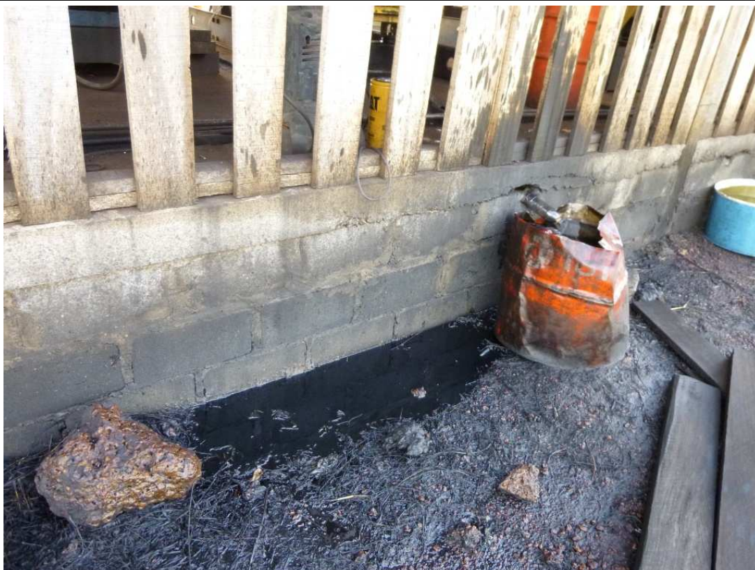
Figure 10 : Huiles usagées déversées suite aux opération de maintenance des Groupes électrogènes (site de Minkio Mibé)
