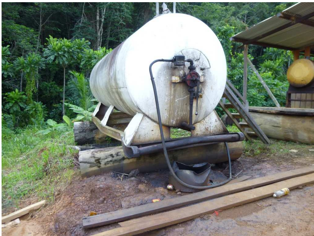
Figure 12 : Citerne d'approvisionnement du site de Mouillage sans rétention
