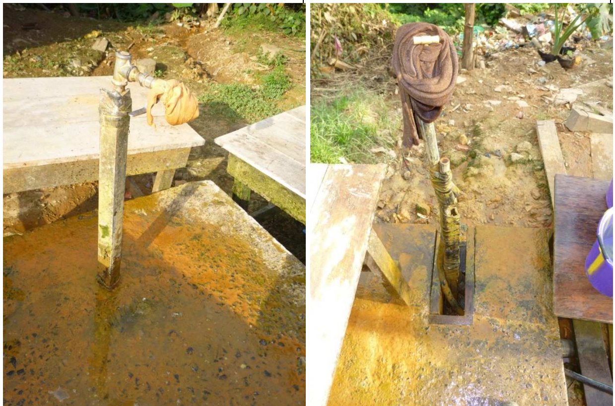
Figure 15 : Robinet de puisage d'eau dans le camp PK7 équipé de dispositif de filtrage
