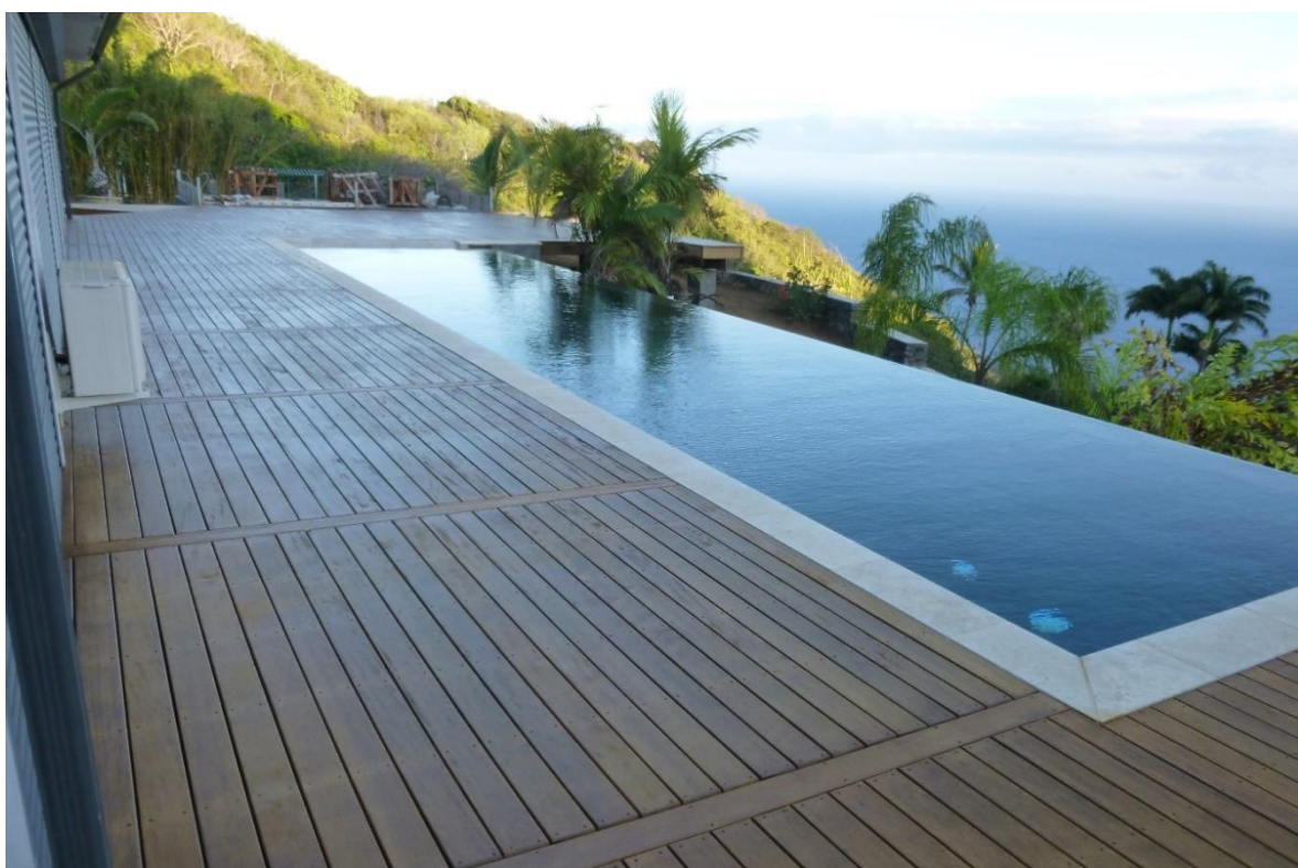
Terrasse en Osanga bordant une piscine à débordement - Fournitures Fibres Industries Bois Réalisation Agencement Tiby , La Réunion (France).
