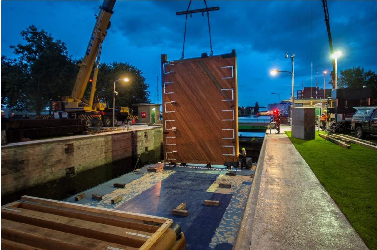
Pose d'une porte d'écluse en Azobé (Société Wijma – Deventer – Pays-Bas) © Wijma
