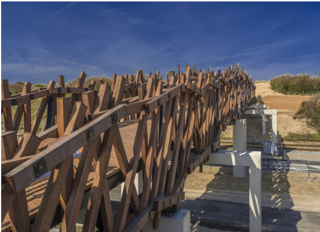
Pont "Het Wrakhout" et son garde-corps (Azobé, Okan and Tali), associés à une piste cyclable et un passage piétonnier – Welduine, Belgique © van Wijma kampen
