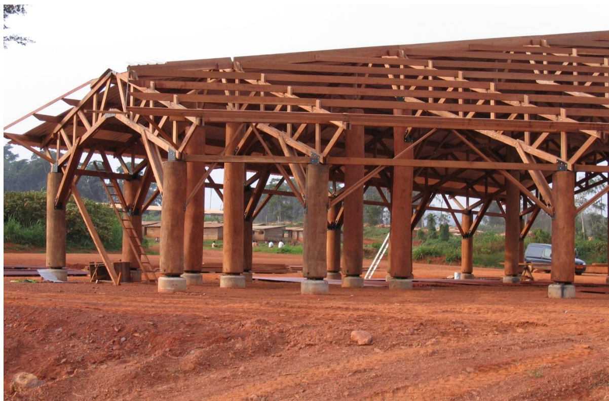
Structure triangulée en Kosipo et poteaux en Tali Réalisation J.-Y. Riaux (Mindourou, Cameroun) © Jean-Yves Riaux
